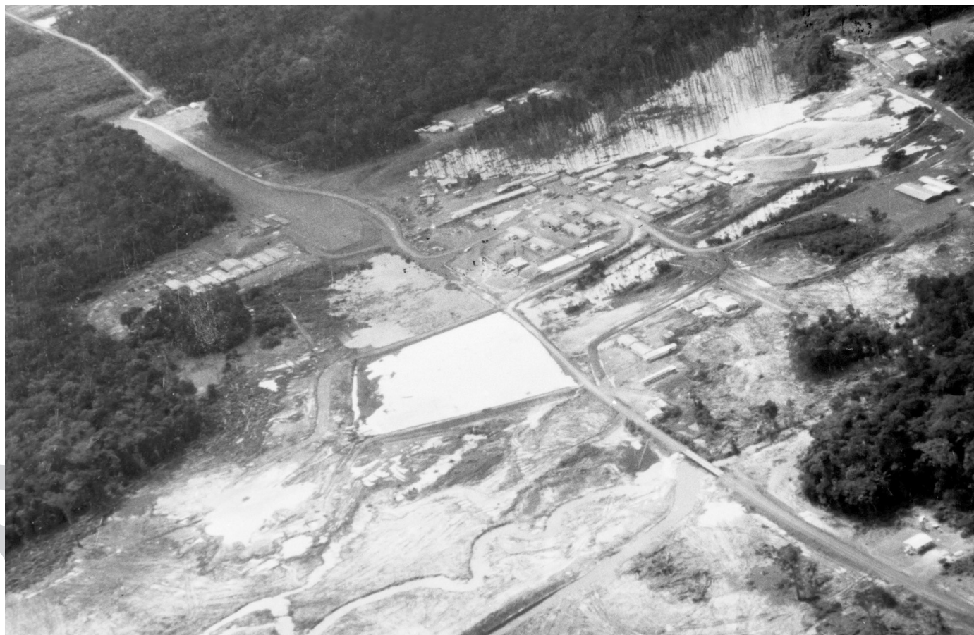
Área de extração de cassiterita da Paranapanema. No canto inferior à direita, o posto da Funai, que ficou fora da demarcação da TI Waimiri Atroari, Amazonas. José Porfírio de Carvalho, 1988.
