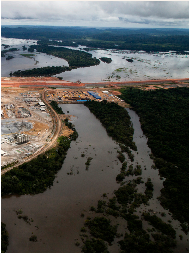
Obras para o desvio do Rio Xingu, construção da Usina Hidrelétrica Belo Monte
