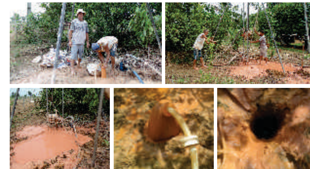
Figura 5.10 Perfuração de um poço semi artesiano na propriedade do produtor Cloves Paulo - Comunidade Céu Azul. Alta Floresta - MT.
