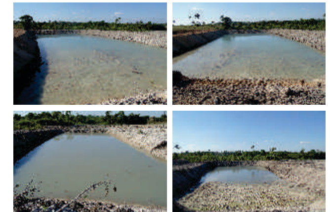
Figuras 7.07, 7.08, 7.09, 7.10, 7.11 e 7.12 - Processo de escavação de viveiros na Piscicultura Carrilho, Comunidade Bela Vista - 09 de junho de 2015 - Alta Floresta-MT
