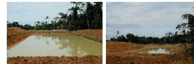
Figuras 7.05 e 7.06 - Processo de escavação de viveiros na Piscicultura Pedra Bonita, Comunidade Monte Alegre - 15 de dezembro de 2014 - Alta Floresta-MT
