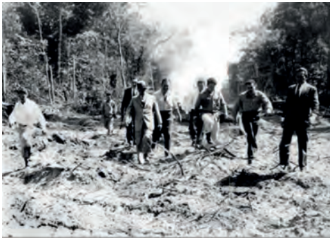
Figura 12 – O presidente da república Juscelino Kubitschek 13 em visita às obras de construção de Brasília
