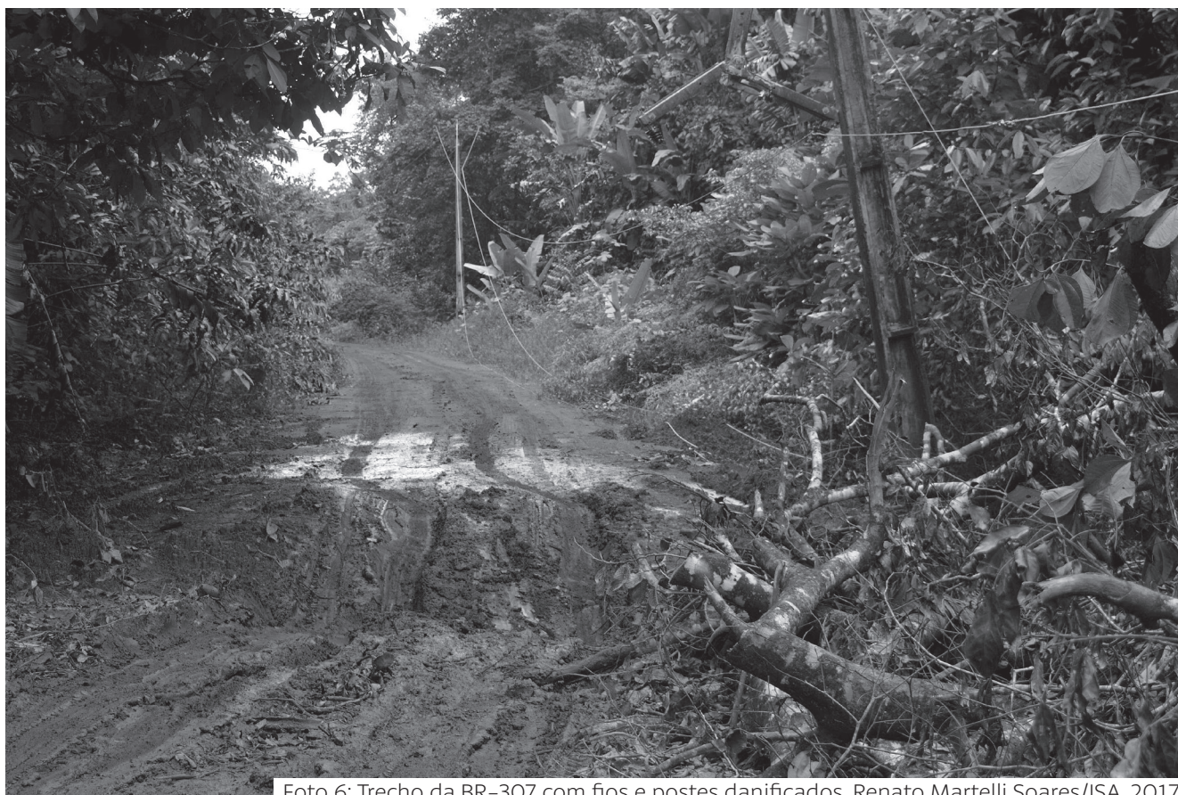
Foto 6: Trecho da BR-307 com fios e postes danificados. Renato Martelli Soares/ISA, 2017
